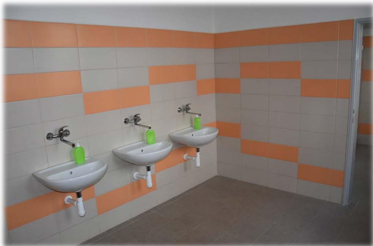
Rekonstruované toalety u školní jídelny
